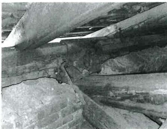
Celkový pohľad na konštrukciu krovu – poškodenie: hniloba a spráchnivenie hlavného trámu
