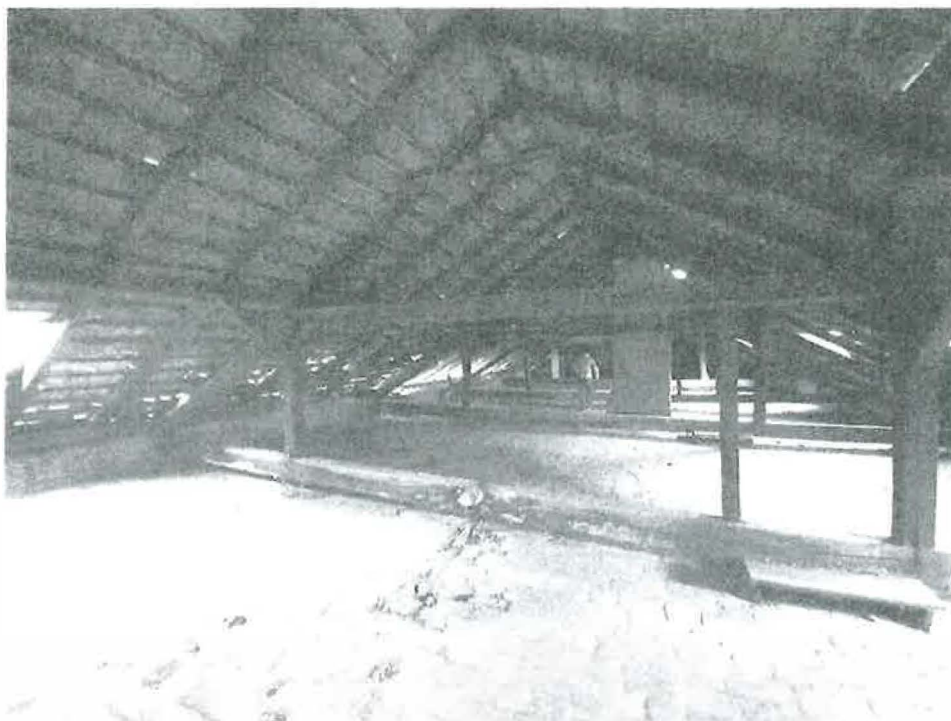
Celkový pohľad na konštrukciu krovu – poškodenie: hniloba a spráchnivenie hlavného trámu
