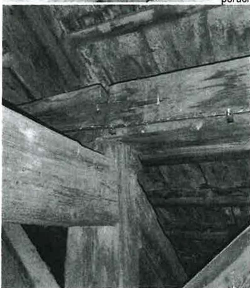
Celkový pohľad na konštrukciu krovu – poškodenie: hniloba a spráchnivenie hlavného trámu
